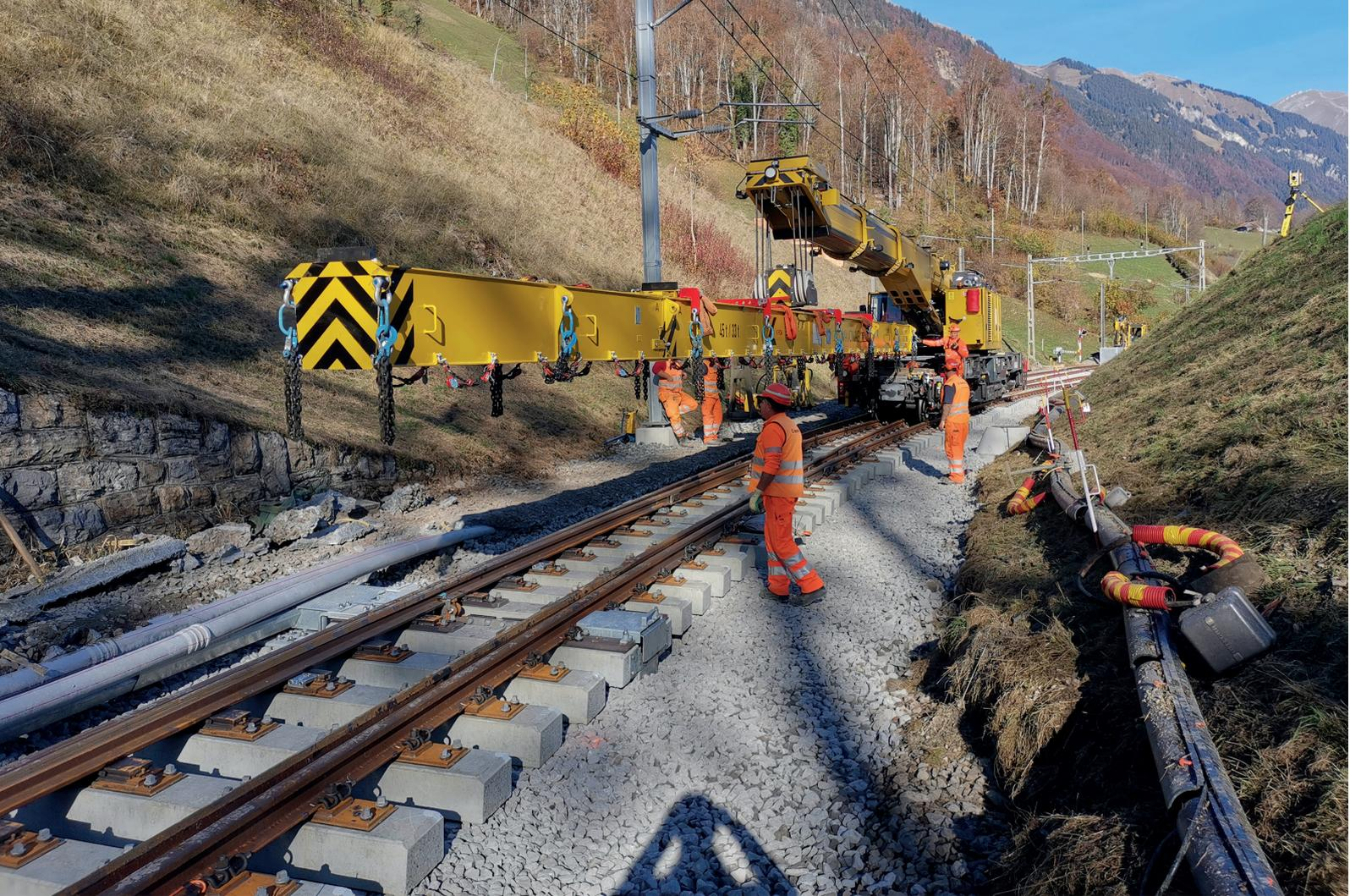
Die neuen Schienenelemente werden vormontiert in das exakt nivellierte Gleisbett eingelegt und im sogenannten Press-Schweißverfahren miteinander verbunden.
