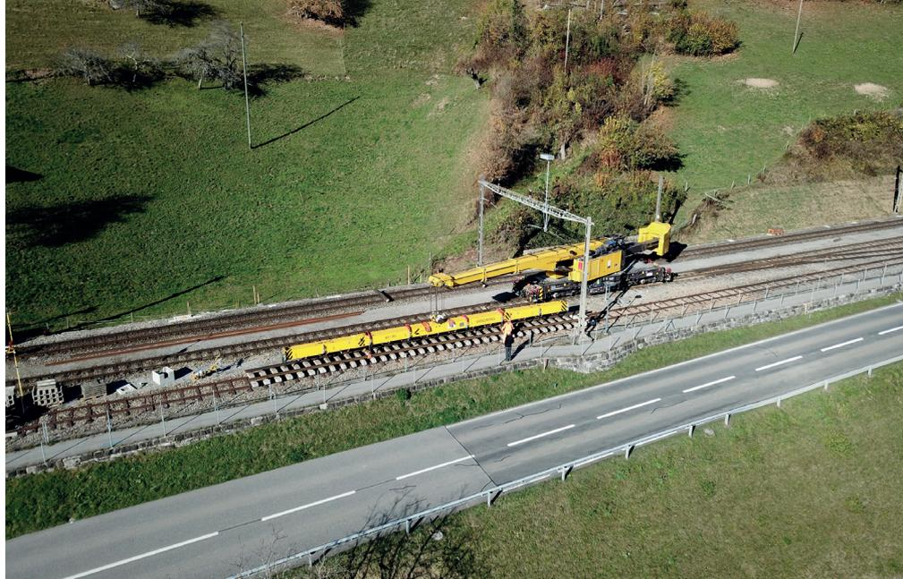
Die Arbeiten am Streckennetz der Schweizer Zentralbahn erfordern höchste Planungskompetenz und in der Realisierungsphase zusätzlich schweres Gerät wie die hier gezeigte Gleisverlegemaschine.
